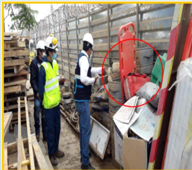
Supervisión Ambiental en instalaciones de la obra Fuente: Equipo técnico
