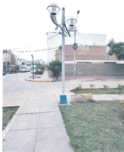
LUMINARIAS ORNAMENTALES OBSOLETAS
