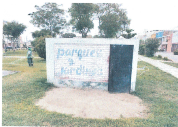
CASETA DE BOMBEO EXISTENTE
