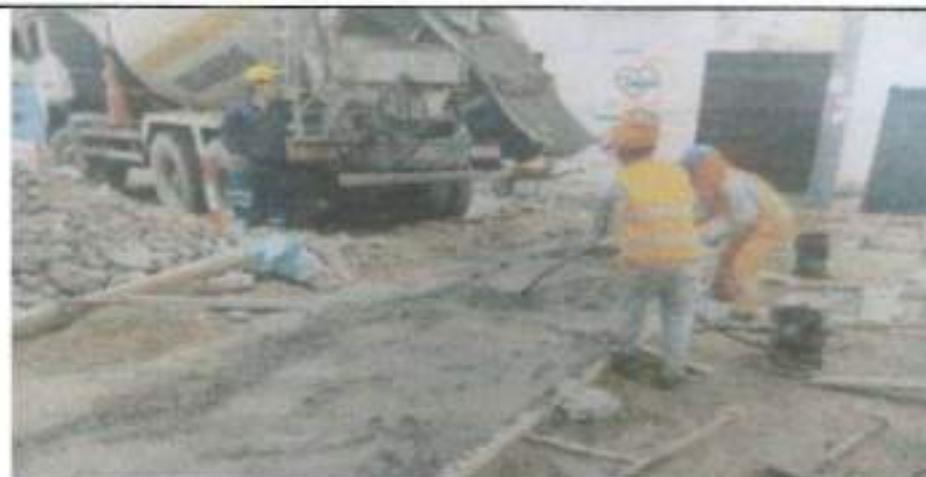
**VACIADO DE CONCRETO PREMEZCLADO PARA LAS CAMELONES**
