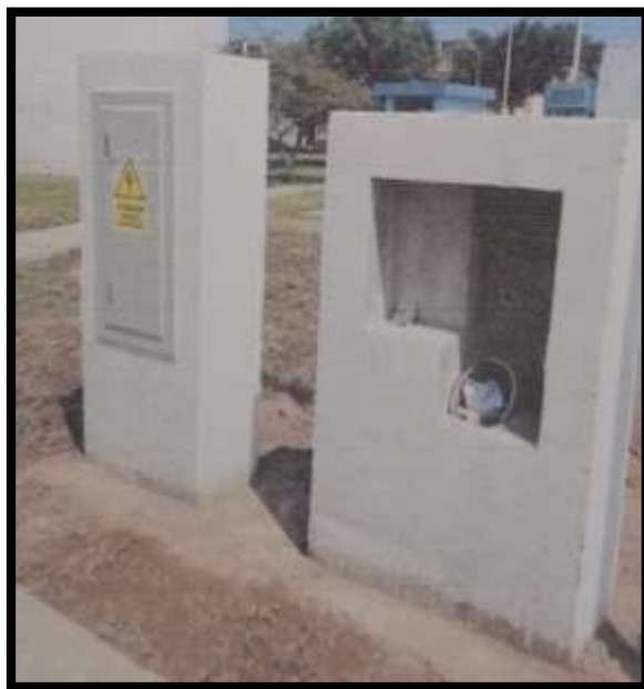
Colocación de muro para tablero
