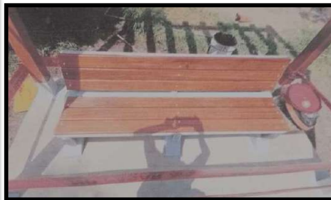
Instalación de bancas de concreto
