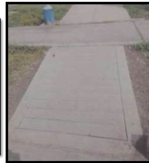
Construcción de rampas de concreto
