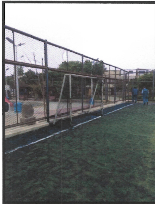
Arcos deportivos en mal estado.
