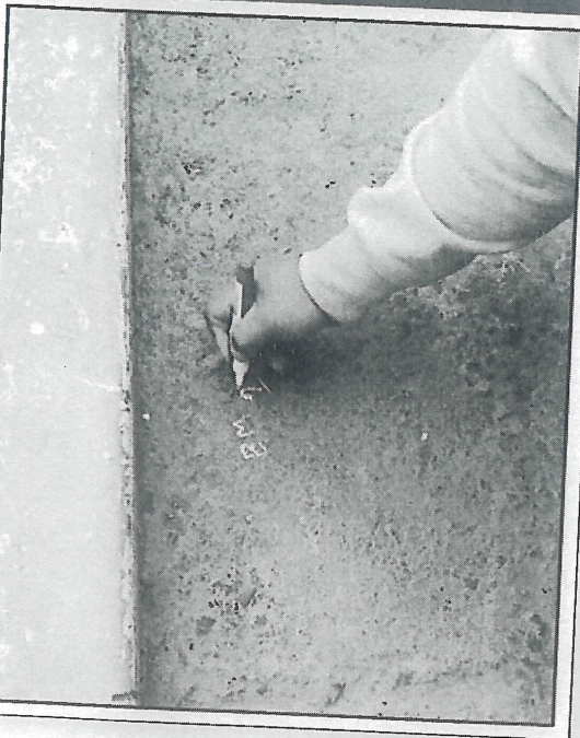
IMAGEN N°16 : Marcación de punto BM-02
