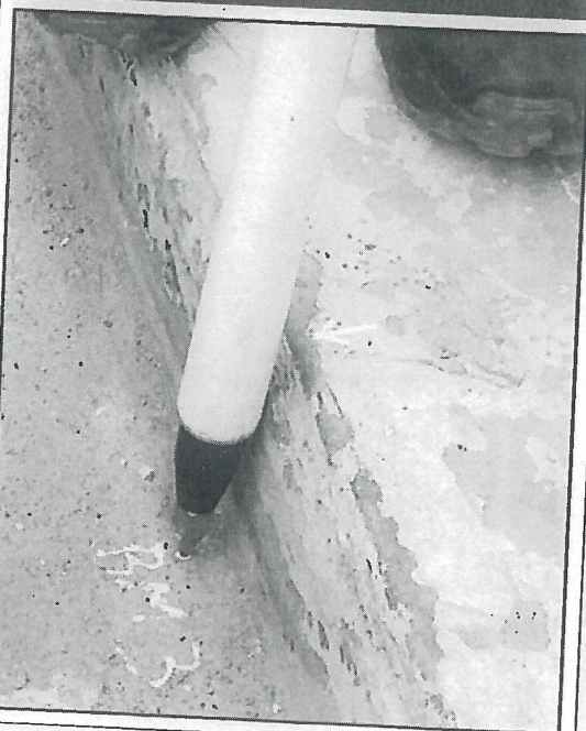
IMAGEN N°18 : Marcación de punto BM-03
