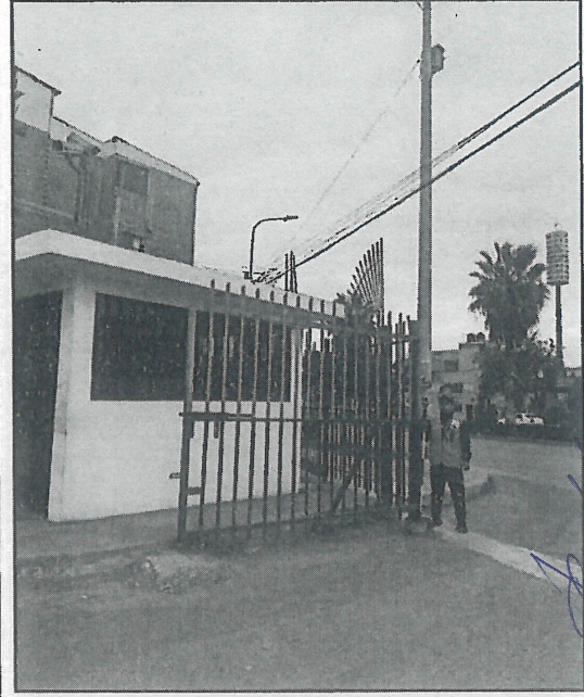
IMAGEN N°2: Ubicación de prismas para la toma de lectura de puntos de reja metálica
