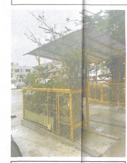
TOMA 3 VISTA DE CERCOS METÁLICOS H: 1.50 M
