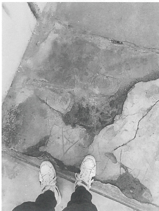
FIGURA 03: Situación actual vereda – Calle 28B
