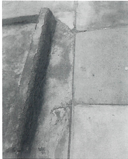
FIGURA 04: Situación actual de sardinel- Calle 45-A
